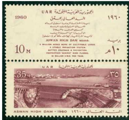
1960, n°s 472/473 Début de la construction du nouveau barrage d'Assouan
