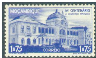
La gare centrale
