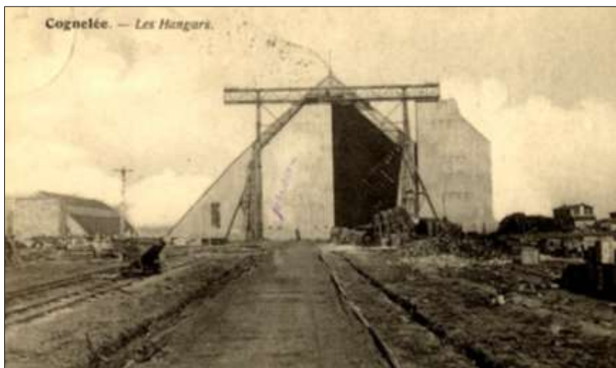
Construction du premier hangar (n° 3, mi-mars 1915) et arrivée des Zeppelins à Cognelée (LZ77, août 1915).
